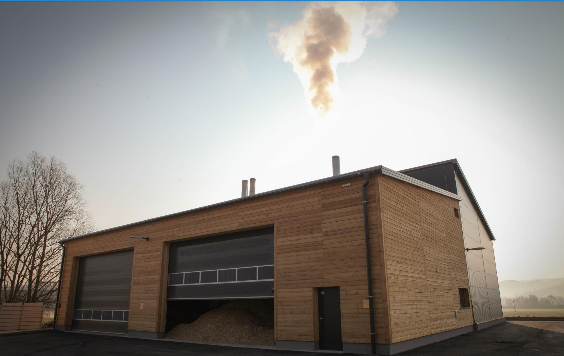
Kotlarna na lesne sekance 2,5 MW
